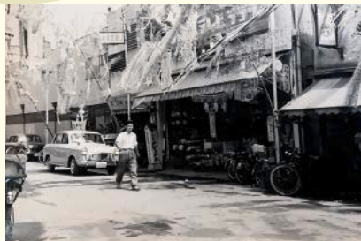
昭和30年頃 七夕 / 磁気シャワー赤井
