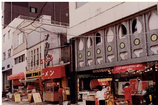
昭和57年 現 プラザ・プリモ付近
